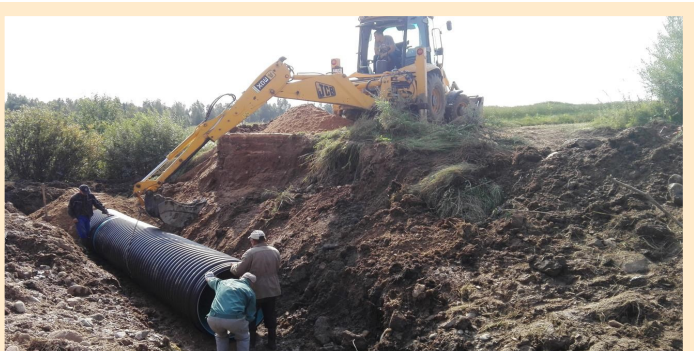
Caurtekas remonts un ceļa atjaunošana Kozlovkā
